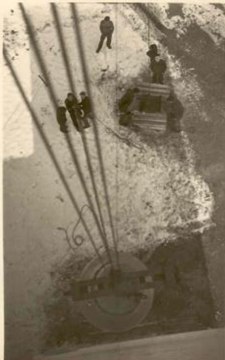
Glockenaufhängen in Handarbeit
