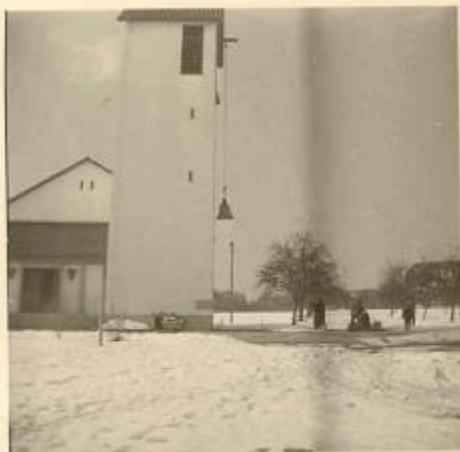
Glockenaufhängen in Handarbeit
